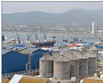
El puerto de Coquimbo espera iniciar la construcción de un nuevo muelle durante el 2019.
